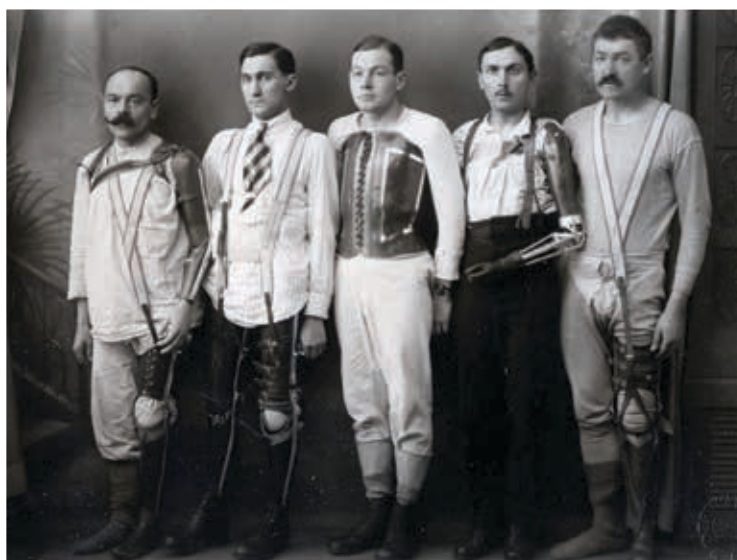
LSK ortopēdiskajā darbnīcā izgatavoto protēžu veidi. Fotogrāfs: J. Rieksts. Rīga, 1923. PSMVM krājums: Falb 12/14
